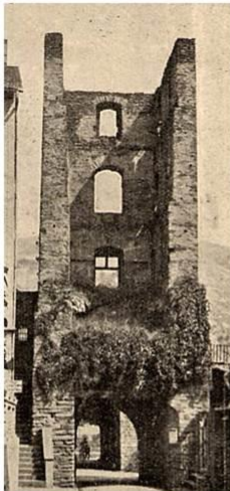
Wie der Marktturm waren alle eckigen Türme in Bacharach als Schalentürme aufgebaut
